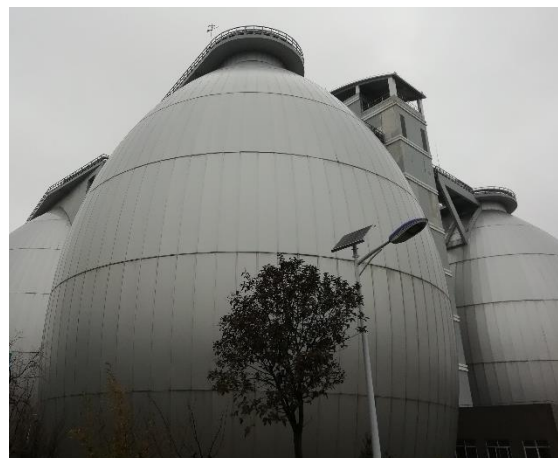
Faultürme einer chinesischen kommunalen Kläranlage
